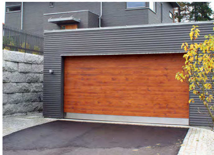
Leddheisport med liggende 16 x 145 mm faspanel i gran. Beiset med Jotun Trebitt 676 Tjærebrun.
