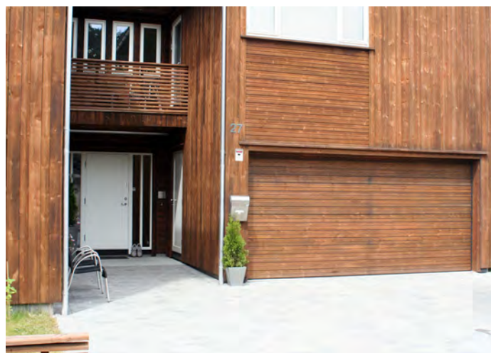
Leddheisport med liggende 16 x 120 mm spesialpanel i gran. Beiset med Jotun Trebitt 623 Burmateak.
