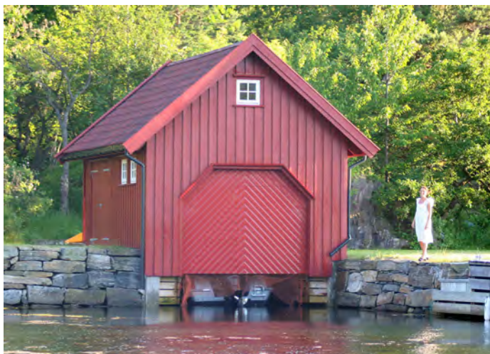
Leddheisport med fiskebensmønster. Panelt med 14 x 124 mm pølsepanel i gran. Beiset med Jotun Trebitt 647 Telemarksrød
